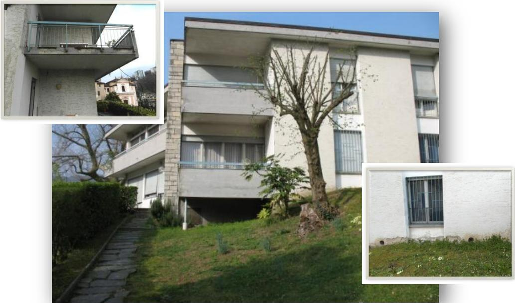
Questi i principali interventi che verranno effettuati: la manutenzione e il rifacimento delle parti deteriorate dei cornicioni del tetto e dei balconi; la sistemazione della pavimentazione esterna al piano terra e al primo piano; la sostituzione dei serramenti; il tinteggio esterno e, parzialmente, dell'appartamento parrocchiale superiore. Si eseguirà inoltre la sistemazione della canalizzazione, e si passerà dal riscaldamento a nafta a quello a gas.
